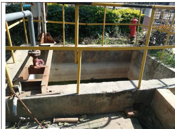
氨站外污水收集池
