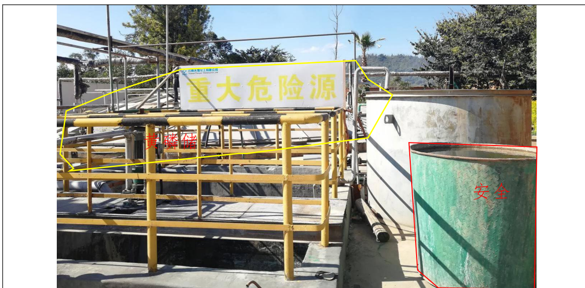
黄磷储罐外标识及应急安全水桶
