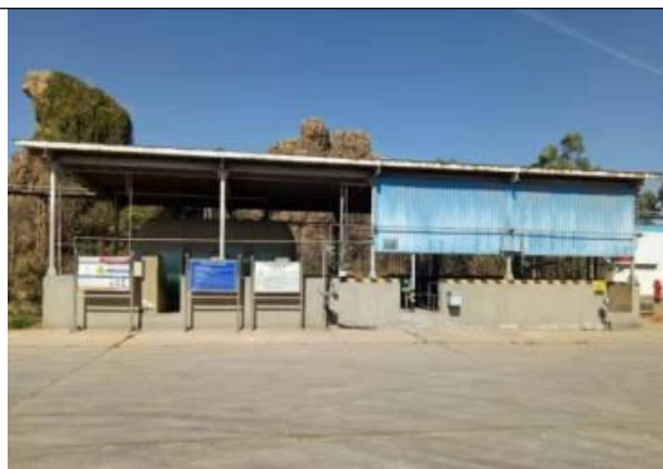
氨站（有标识、设围堰）
