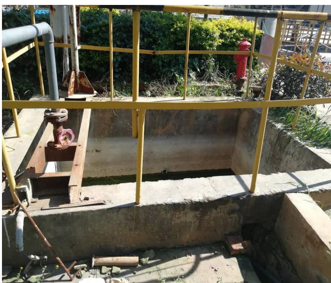
氨站外污水收集池
