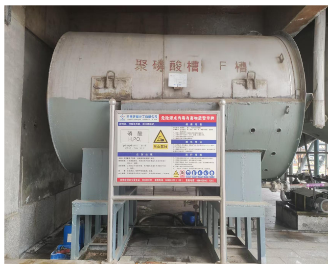
磷酸储罐区标识牌、围堰
